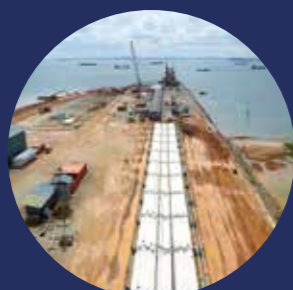
Serviços de construção de tubulações da "spool base" (base de bobinamento)
