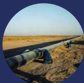
Serviços de revestimento de juntas de campo
