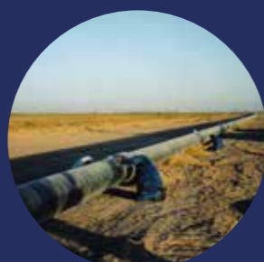
Serviços de revestimento de juntas de campo
