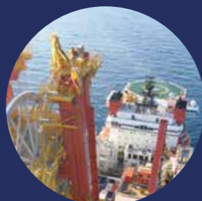
Serviços de construção de tubulações offshore
